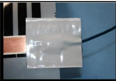
04. 6 Fixarea banda izolatoare impermeabilă de sus
