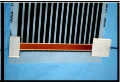
04. 8 Fixarea banda izolatoare impermeabilă sigilarea capetelor foliei de încălzire
