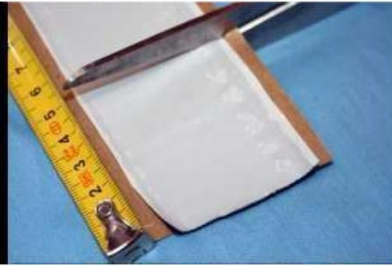
04. 1 Tăierea la dimensiune a bandei izolatoare impermeabilă
