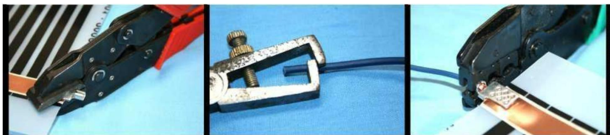
03.1 Conectarea conectorului argintiu și a cablului electric cu unealta specială de sertizare
