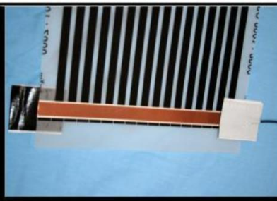
04. 7 Fixarea banda izolatoare impermeabilă sigilarea capetelor foliei de încălzire
